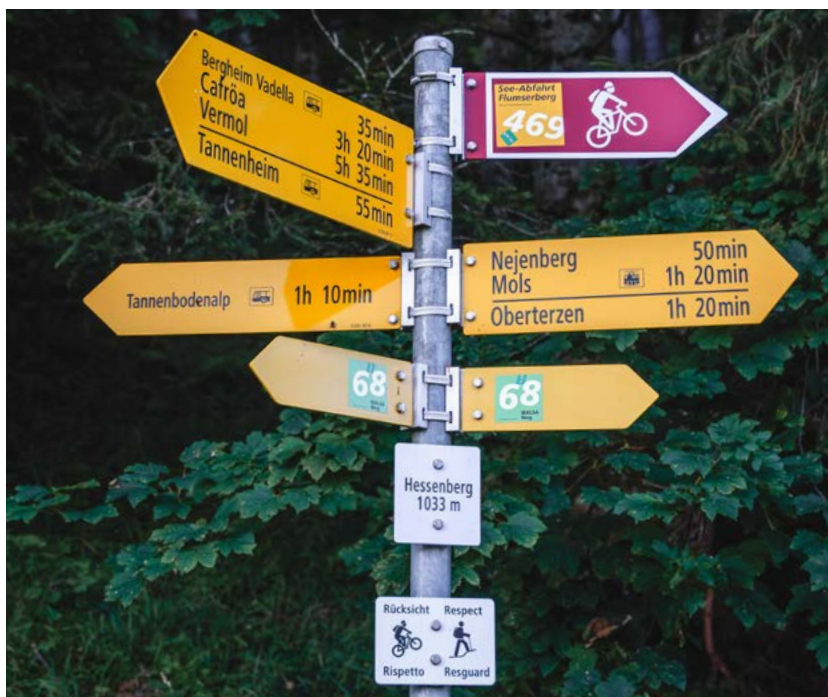
Image 8-1 : Exemple d'indicateur de direction avec champ de désignation d'itinéraire, installé correctement au-dessus du balisage du chemin de randonnée pédestre
