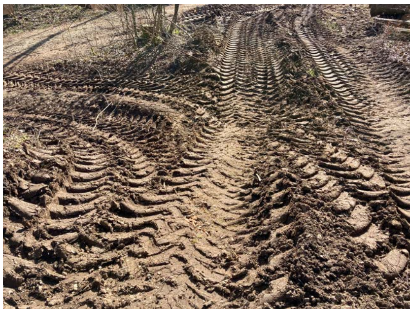
Fig. 8 Chemin après des travaux forestiers
